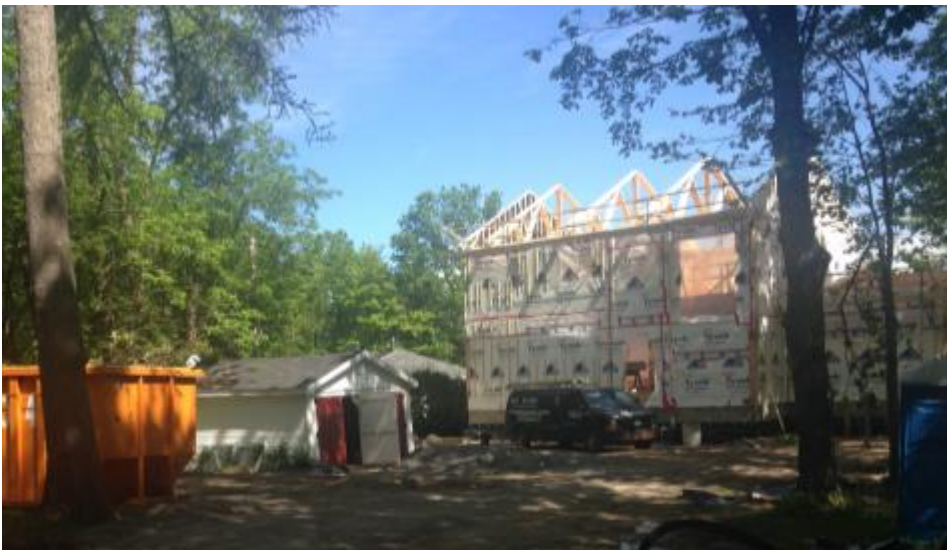
Figure 2 Construction de la nouvelle résidence principale (juin 2017)
